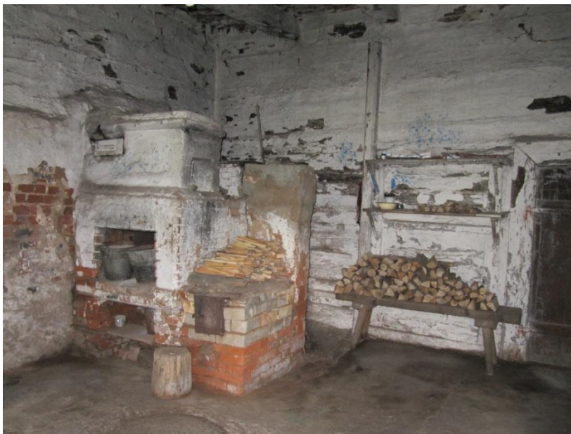
F.F.-006.p.namas i-17 /plytų mūro duonkepė krosnis su virykle virtuvėje/
